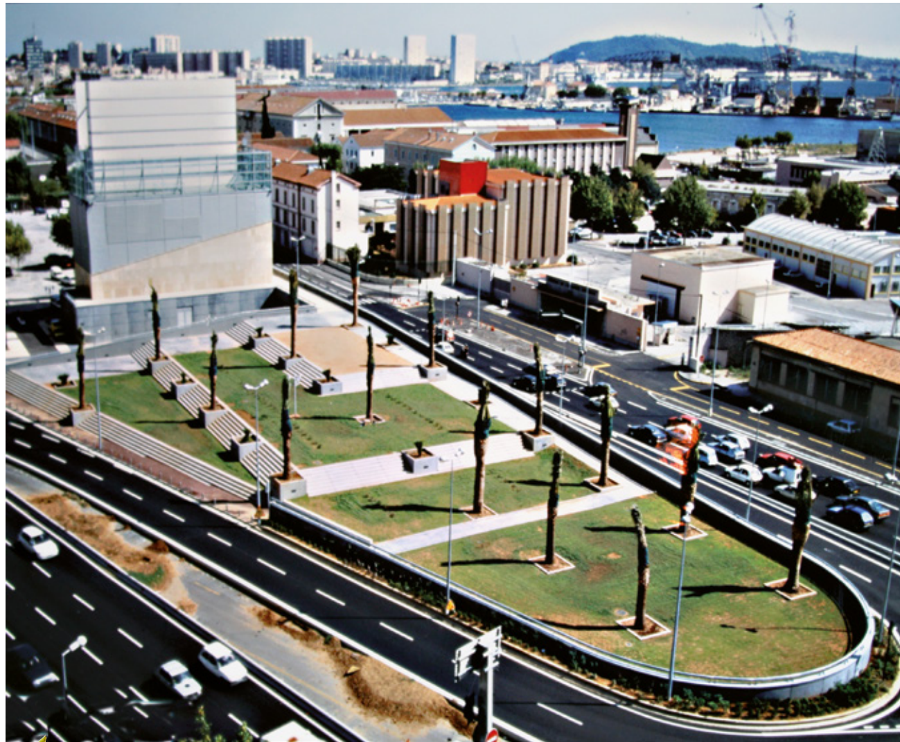
Traversée souterraine de Toulon
