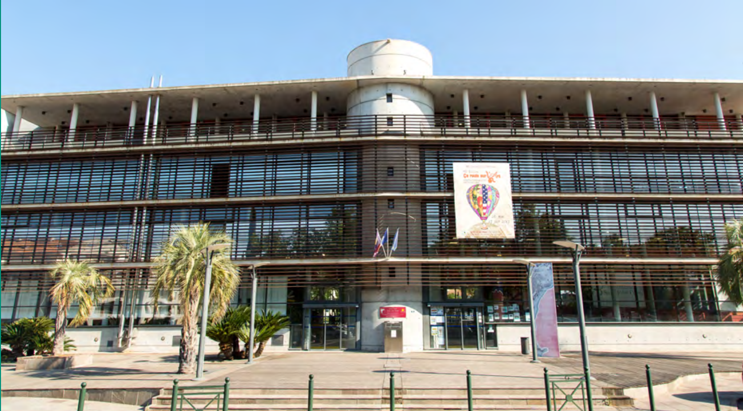
Médiathèque de Hyères
